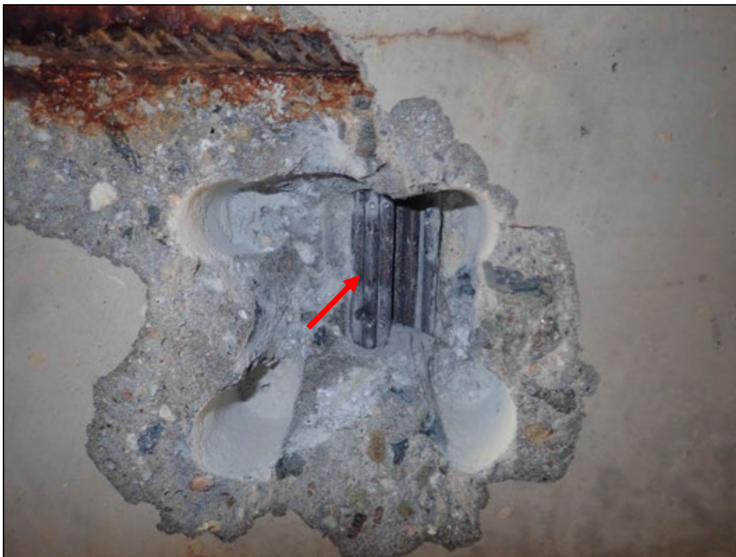
Foto 25: Detail sondy S25, předpínací výztuž nosník KA 61, spodní líc nosníku č. 9, cca 1/2 rozpětí. Na předpínací výztuži nebyla nalezena koroze. Kanálek zcela vyplněn injektážní směsí. Krytí předpínací výztuže cca 40 mm. Poloha viz Příloha 1.
