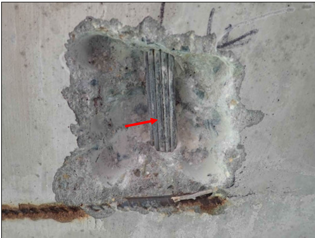
Foto 1: Detail sondy S1, předpínací výztuž nosník KA 61, spodní líc nosníku č. 1, cca 1/3 rozpětí. Na předpínací výztuži nebyla nalezena koroze. Kanálek zcela vyplněn injektážní směsí. Krytí předpínací výztuže cca 40 mm. Poloha viz Příloha 1.
