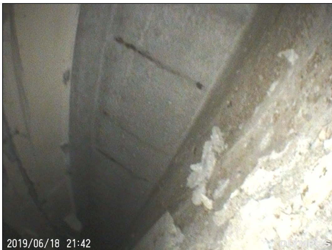
Foto 6: Detail vnitřního povrchu komory nosníku. Sonda E6, nosník č. 10. Lokální koroze měkké výztuže nosníků.
