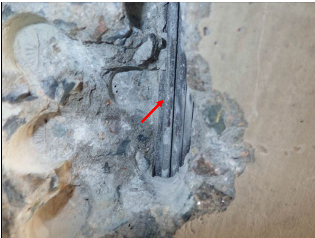
Foto 29: Detail sondy S29, předpínací výztuž nosník KA 61, spodní líc nosníku č. 13, cca 1/2 rozpětí. Na předpínací výztuži nebyla nalezena koroze. Kanálek zcela vyplněn injektážní směsí. Krytí předpínací výztuže cca 40 mm. Poloha viz Příloha 1.
