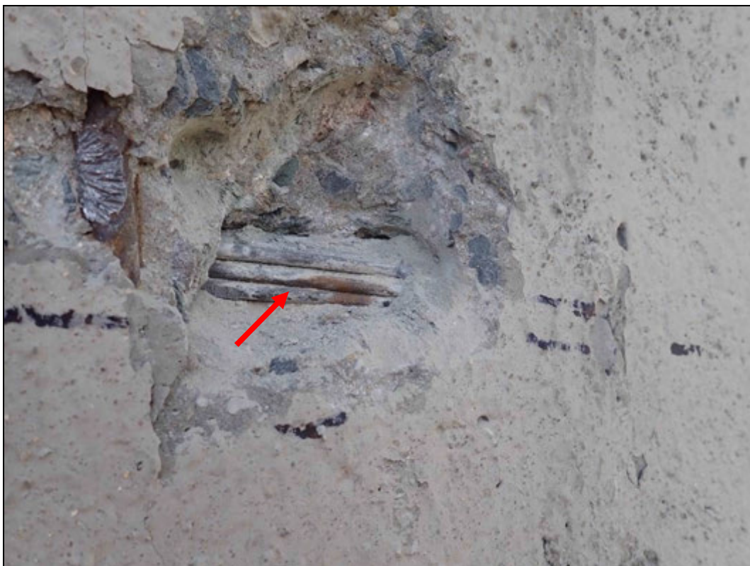
Foto 32: Detail sondy S32, předpínací výztuž nosník KA 61, bok nosníku č. 1, podkotevní oblast. Na předpínací výztuži byla nalezena drobná povrchová koroze. Kanálek zcela vyplněn injektážní směsí. Krytí předpínací výztuže cca 30 mm. Poloha viz Příloha 1.
