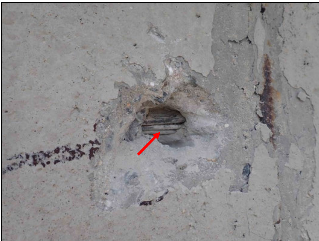
Foto 16: Detail sondy S16, předpínací výztuž nosník KA 61, bok nosníku č. 1, podkotevní oblast. Na předpínací výztuži nebyla nalezena koroze. Kanálek zcela vyplněn injektážní směsí. Krytí předpínací výztuže cca 35 mm. Poloha viz Příloha 1.
