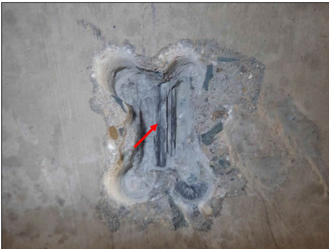
Foto 8: Detail sondy S8, předpínací výztuž nosník KA 61, spodní líc nosníku č. 8, cca 1/3 rozpětí. Na předpínací výztuži nebyla nalezena koroze. Kanálek zcela vyplněn injektážní směsí. Krytí předpínací výztuže cca 40 mm. Poloha viz Příloha 1.
