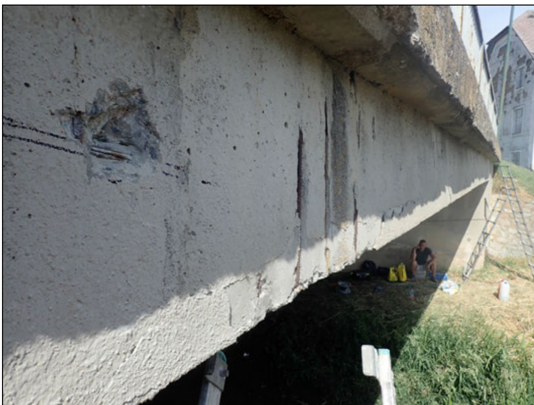
Foto 6: Pohled na bok nosné konstrukce. Provedená sonda k předpínací výztuži v podkotevní oblasti.
