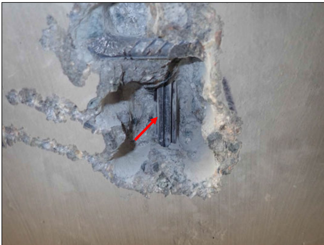
Foto 6: Detail sondy S6, předpínací výztuž nosník KA 61, spodní líc nosníku č. 6, cca 1/3 rozpětí. Na předpínací výztuži nebyla nalezena koroze. Kanálek zcela vyplněn injektážní směsí. Krytí předpínací výztuže cca 45 mm. Poloha viz Příloha 1.
