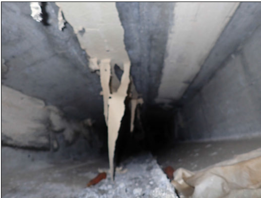
Foto 2: Detail vnitřního povrchu komory nosníku. Sonda E2 v místě vrtu V2. Nosník č. 11. Lokální koroze měkké výztuže nosníků.
