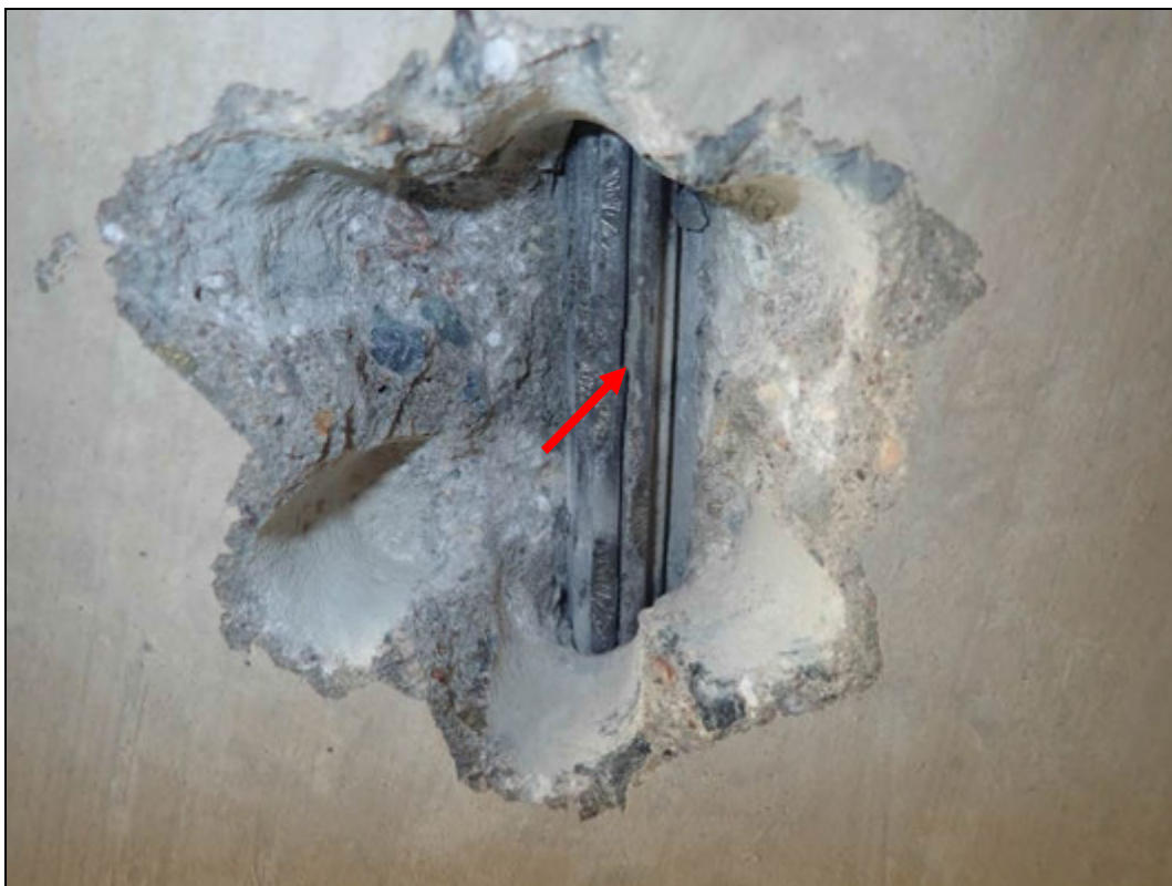
Foto 4: Detail sondy S4, předpínací výztuž nosník KA 61, spodní líc nosníku č. 4, cca 1/3 rozpětí. Na předpínací výztuži nebyla nalezena koroze. Kanálek zcela vyplněn injektážní směsí. Krytí předpínací výztuže cca 45 mm. Poloha viz Příloha 1.
