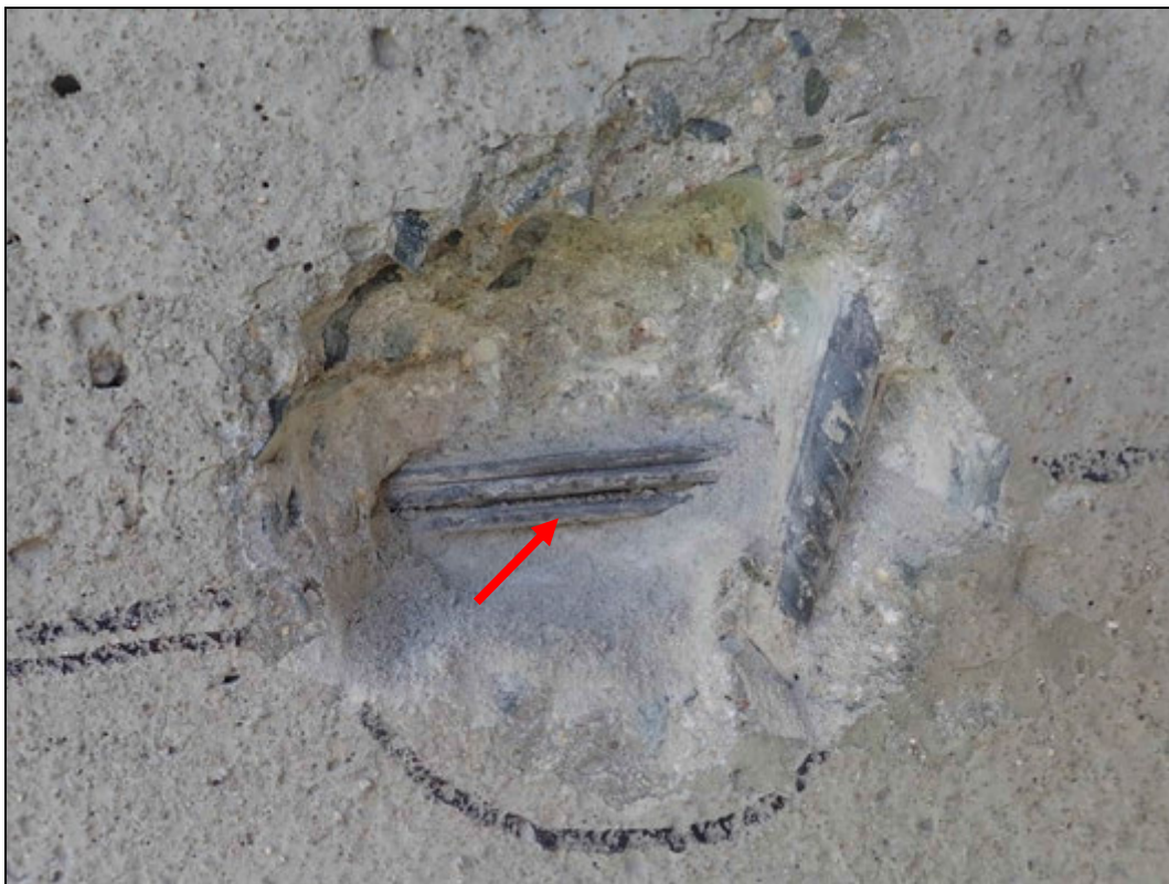
Foto 31: Detail sondy S31, předpínací výztuž nosník KA 61, bok nosníku č. 14, podkotevní oblast. Na předpínací výztuži nebyla nalezena koroze. Kanálek zcela vyplněn injektážní směsí. Krytí předpínací výztuže cca 30 mm. Poloha viz Příloha 1.
