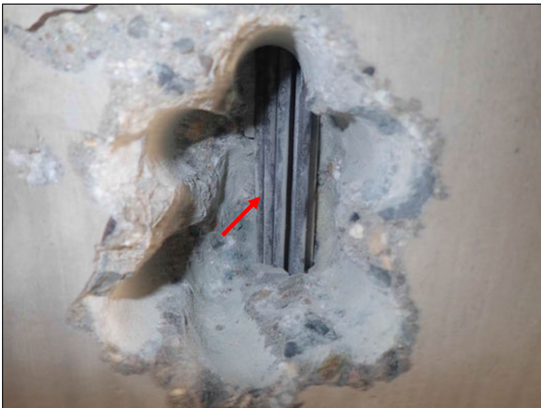
Foto 12: Detail sondy S12, předpínací výztuž nosník KA 61, spodní líc nosníku č. 12, cca 1/3 rozpětí. Na předpínací výztuži nebyla nalezena koroze. Kanálek zcela vyplněn injektážní směsí. Krytí předpínací výztuže cca 50 mm. Poloha viz Příloha 1.
