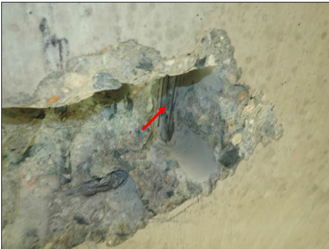
Foto 17: Detail sondy S17, předpínací výztuž nosník KA 61, spodní líc nosníku č. 1, cca 1/2 rozpětí. Na předpínací výztuži nebyla nalezena koroze. Kanálek zcela vyplněn injektážní směsí. Krytí předpínací výztuže cca 50 mm. Poloha viz Příloha 1.
