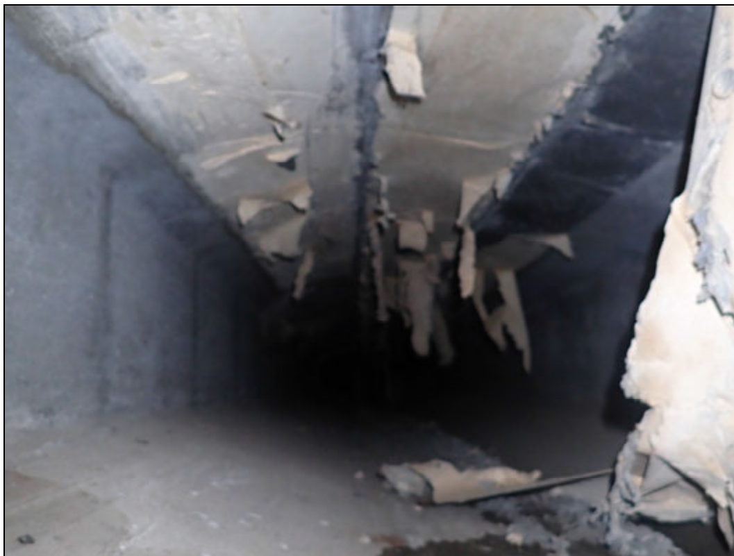
Foto 1: Detail vnitřního povrchu komory nosníku. Sonda E1 v místě vrtu V1. Nosník č. 14. Lokální koroze měkké výztuže nosníků.
