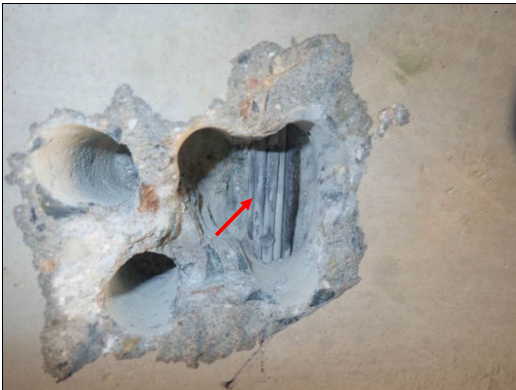
Foto 13: Detail sondy S13, předpínací výztuž nosník KA 61, spodní líc nosníku č. 13, cca 1/3 rozpětí. Na předpínací výztuži nebyla nalezena koroze. Kanálek zcela vyplněn injektážní směsí. Krytí předpínací výztuže cca 45 mm. Poloha viz Příloha 1.
