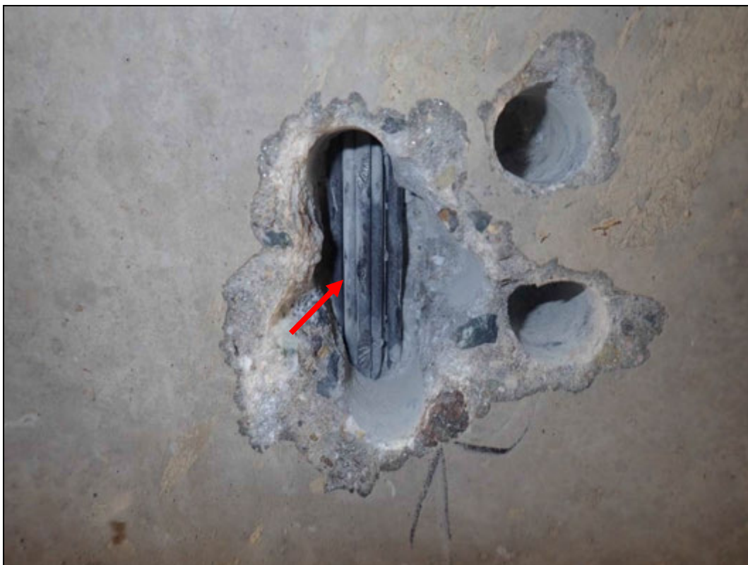
Foto 24: Detail sondy S24, předpínací výztuž nosník KA 61, spodní líc nosníku č. 8, cca 1/2 rozpětí. Na předpínací výztuži nebyla nalezena koroze. Kanálek zcela vyplněn injektážní směsí. Krytí předpínací výztuže cca 40 mm. Poloha viz Příloha 1.
