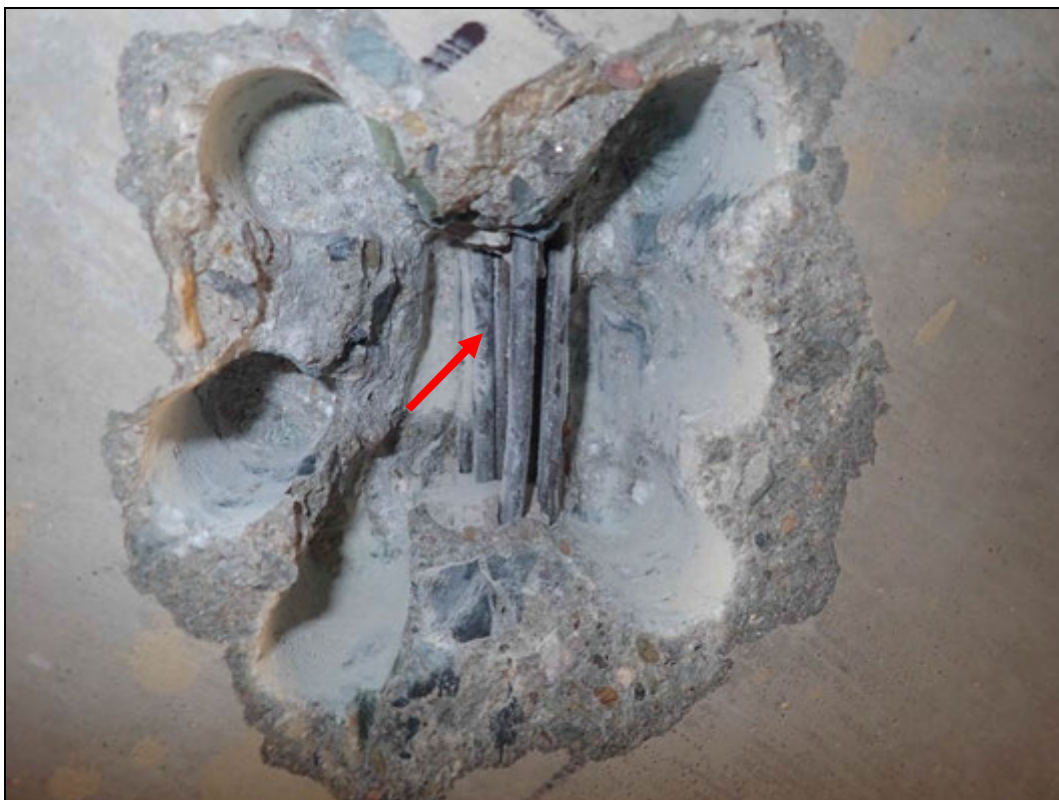
Foto 10: Detail sondy S10, předpínací výztuž nosník KA 61, spodní líc nosníku č. 10, cca 1/3 rozpětí. Na předpínací výztuži nebyla nalezena koroze. Kanálek zcela vyplněn injektážní směsí. Krytí předpínací výztuže cca 40 mm. Poloha viz Příloha 1.
