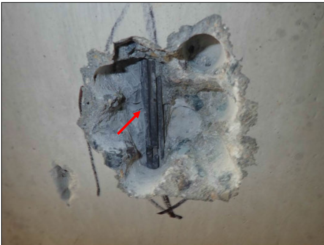
Foto 20: Detail sondy S20, předpínací výztuž nosník KA 61, spodní líc nosníku č. 4, cca 1/2 rozpětí. Na předpínací výztuži nebyla nalezena koroze. Kanálek zcela vyplněn injektážní směsí. Krytí předpínací výztuže cca 30 mm. Poloha viz Příloha 1.
