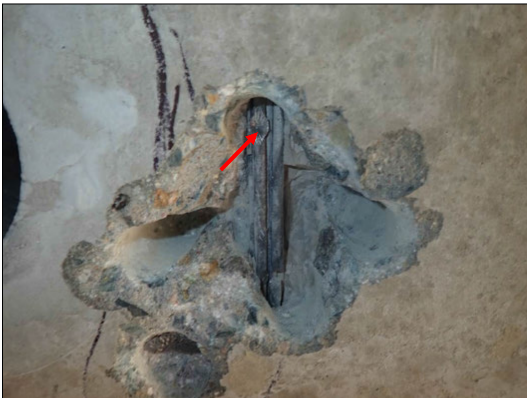
Foto 14: Detail sondy S14, předpínací výztuž nosník KA 61, spodní líc nosníku č. 14, cca 1/3 rozpětí. Na předpínací výztuži nebyla nalezena koroze. Kanálek zcela vyplněn injektážní směsí. Krytí předpínací výztuže cca 30 mm. Poloha viz Příloha 1.
