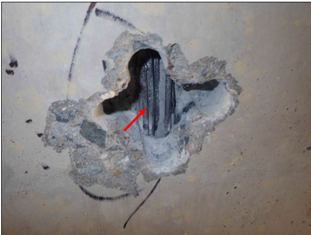
Foto 23: Detail sondy S23, předpínací výztuž nosník KA 61, spodní líc nosníku č. 7, cca 1/2 rozpětí. Na předpínací výztuži nebyla nalezena koroze. Kanálek zcela vyplněn injektážní směsí. Krytí předpínací výztuže cca 35 mm. Poloha viz Příloha 1.
