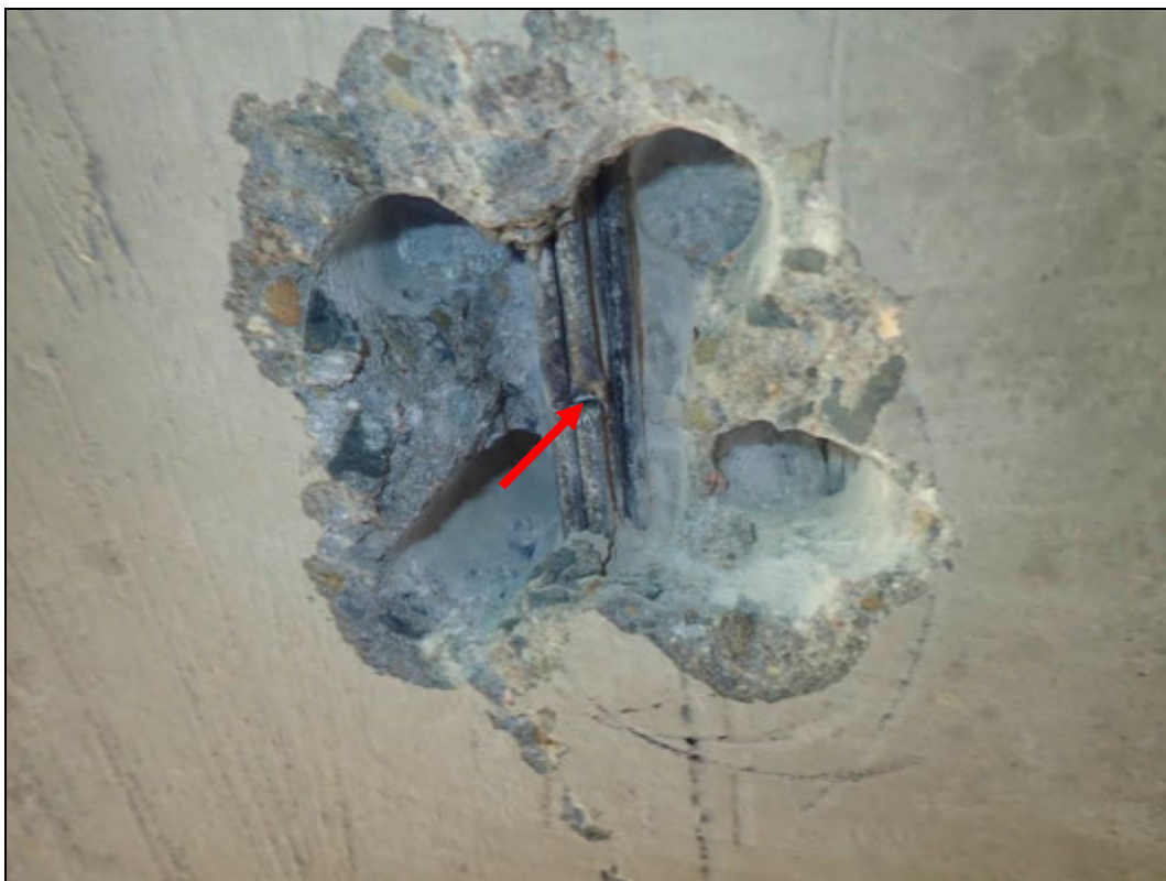
Foto 30: Detail sondy S30, předpínací výztuž nosník KA 61, spodní líc nosníku č. 14, cca 1/2 rozpětí. Na předpínací výztuži nebyla nalezena koroze. Kanálek zcela vyplněn injektážní směsí. Krytí předpínací výztuže cca 25 mm. Poloha viz Příloha 1.
