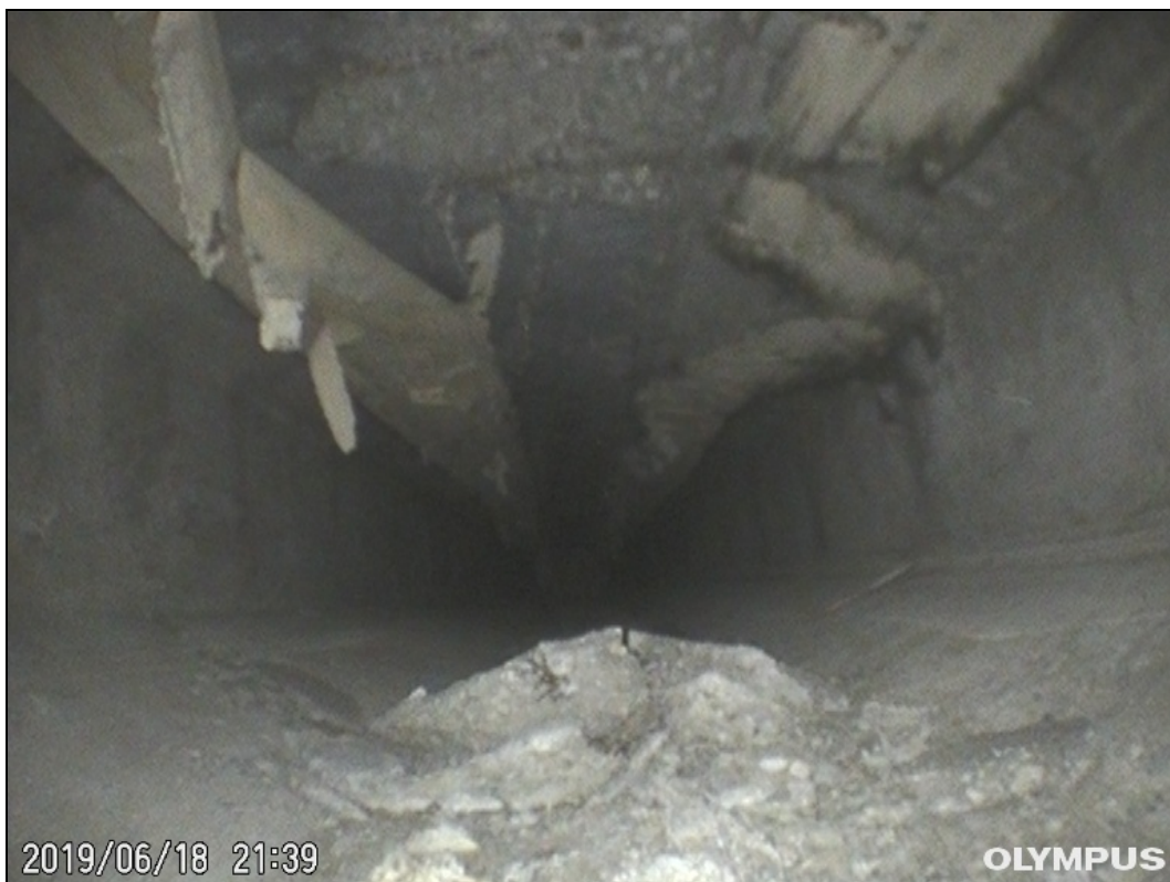
Foto 4: Detail vnitřního povrchu komory nosníku. Sonda E4, nosník č. 13. Lokální koroze měkké výztuže nosníků.
