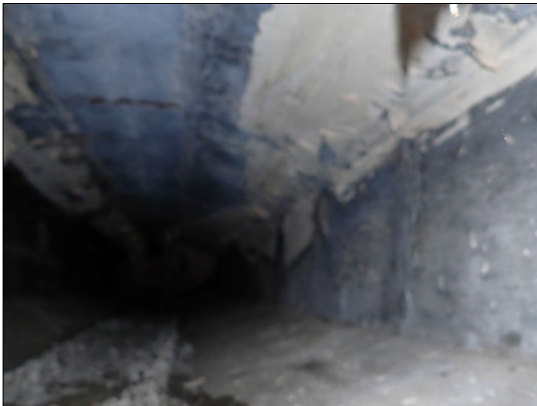
Foto 3: Detail vnitřního povrchu komory nosníku. Sonda E3 v místě vrtu V3. Nosník č. 1. Stopy po zatékání spojené s výluhy. Koroze měkké výztuže nosníků.
