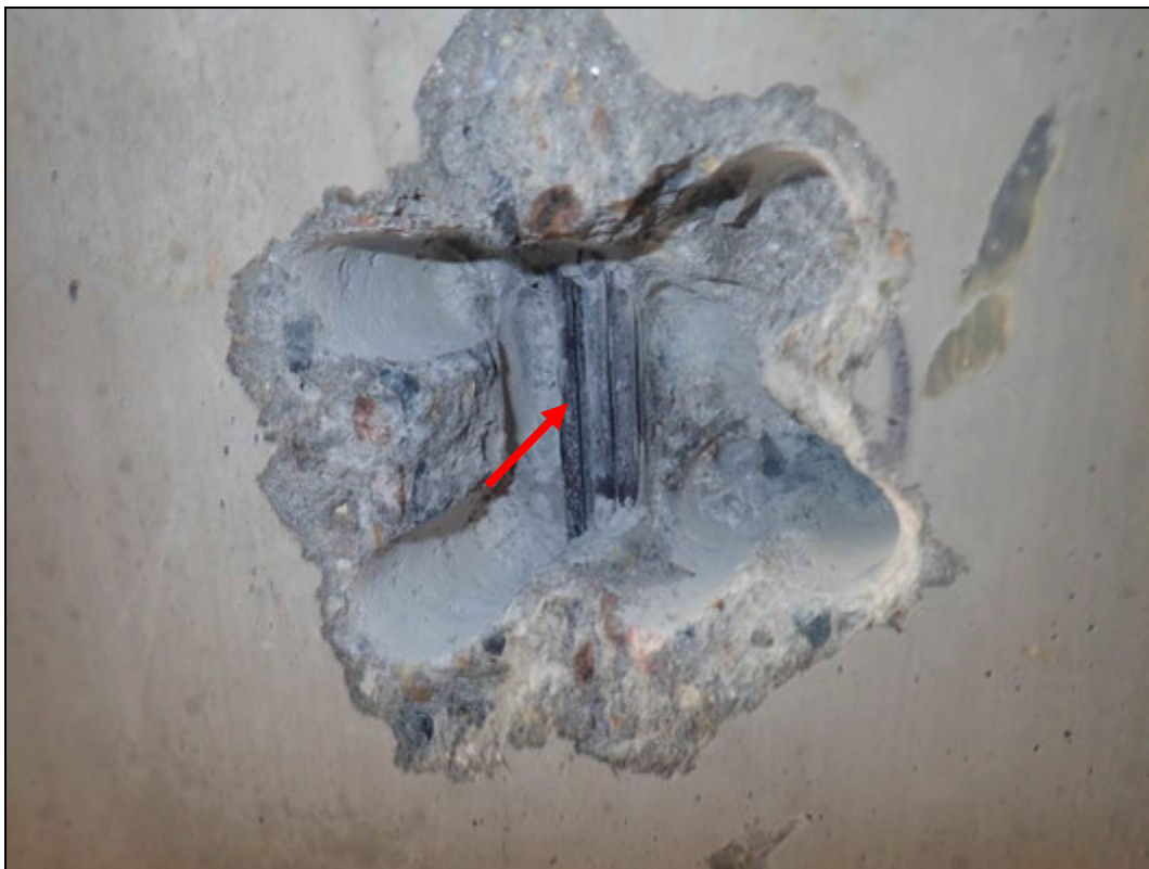
Foto 21: Detail sondy S21, předpínací výztuž nosník KA 61, spodní líc nosníku č. 5, cca 1/2 rozpětí. Na předpínací výztuži nebyla nalezena koroze. Kanálek zcela vyplněn injektážní směsí. Krytí předpínací výztuže cca 38 mm. Poloha viz Příloha 1.
