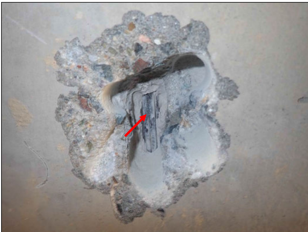
Foto 26: Detail sondy S26, předpínací výztuž nosník KA 61, spodní líc nosníku č. 10, cca 1/2 rozpětí. Na předpínací výztuži nebyla nalezena koroze. Kanálek zcela vyplněn injektážní směsí. Krytí předpínací výztuže cca 50 mm. Poloha viz Příloha 1.
