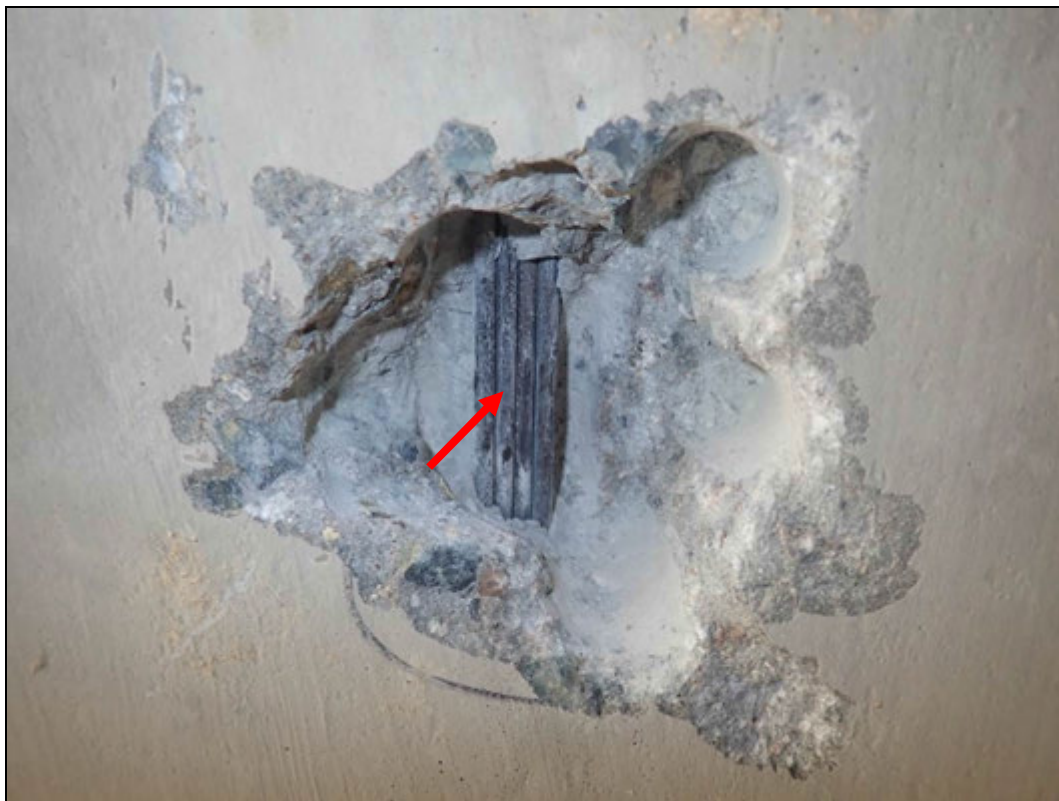
Foto 5: Detail sondy S5, předpínací výztuž nosník KA 61, spodní líc nosníku č. 5, cca 1/3 rozpětí. Na předpínací výztuži nebyla nalezena koroze. Kanálek zcela vyplněn injektážní směsí. Krytí předpínací výztuže cca 40 mm. Poloha viz Příloha 1.
