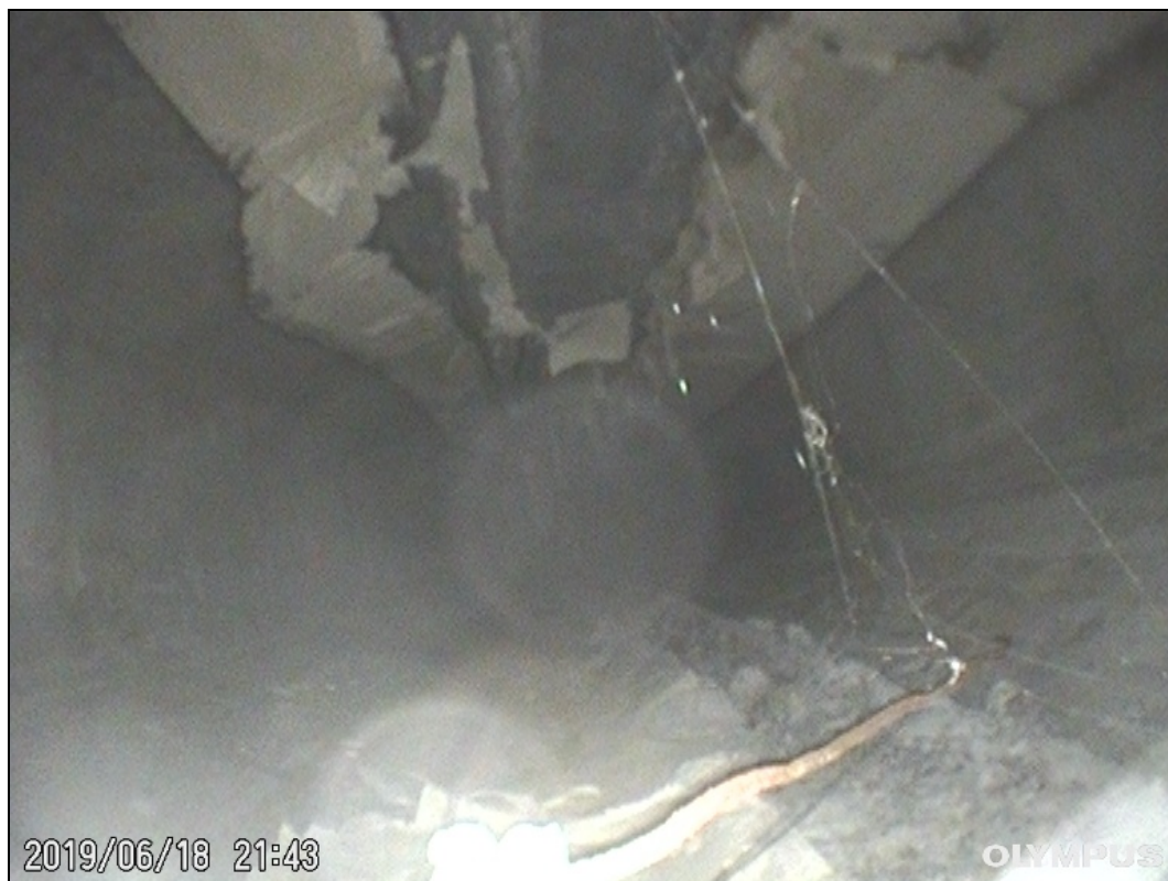
Foto 7: Detail vnitřního povrchu komory nosníku. Sonda E7, nosník č. 9. Lokální koroze měkké výztuže nosníků.
