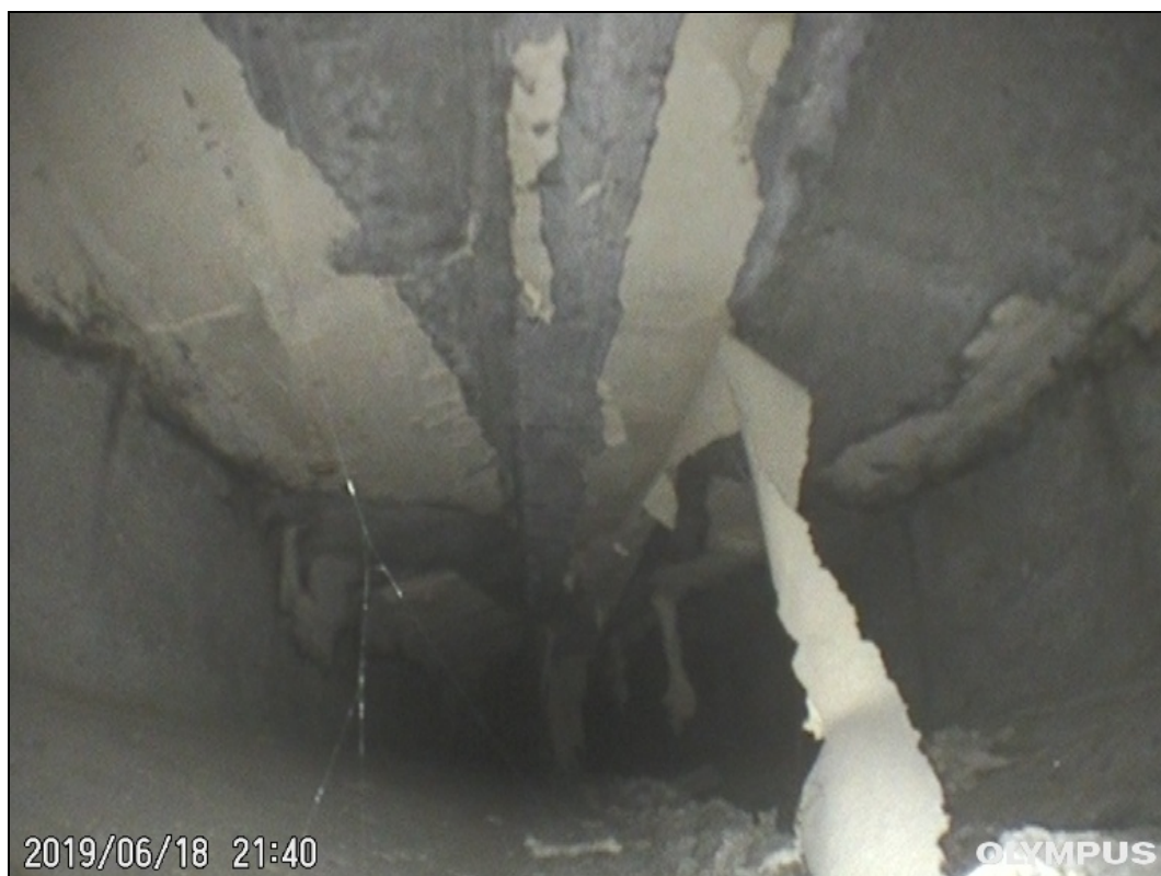
Foto 5: Detail vnitřního povrchu komory nosníku. Sonda E5, nosník č. 12. Lokální koroze měkké výztuže nosníků.
