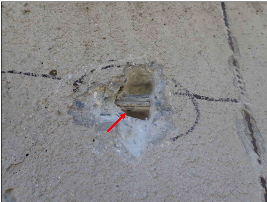
Foto 15: Detail sondy S15, předpínací výztuž nosník KA 61, bok nosníku č. 14, podkotevní oblast. Na předpínací výztuži nebyla nalezena koroze. Kanálek zcela vyplněn injektážní směsí. Krytí předpínací výztuže cca 30 mm. Poloha viz Příloha 1.
