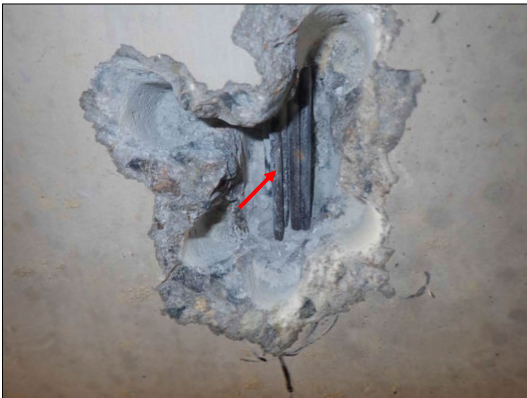
Foto 22: Detail sondy S22, předpínací výztuž nosník KA 61, spodní líc nosníku č. 6, cca 1/2 rozpětí. Na předpínací výztuži nebyla nalezena koroze. Kanálek zcela vyplněn injektážní směsí. Krytí předpínací výztuže cca 35 mm. Poloha viz Příloha 1.
