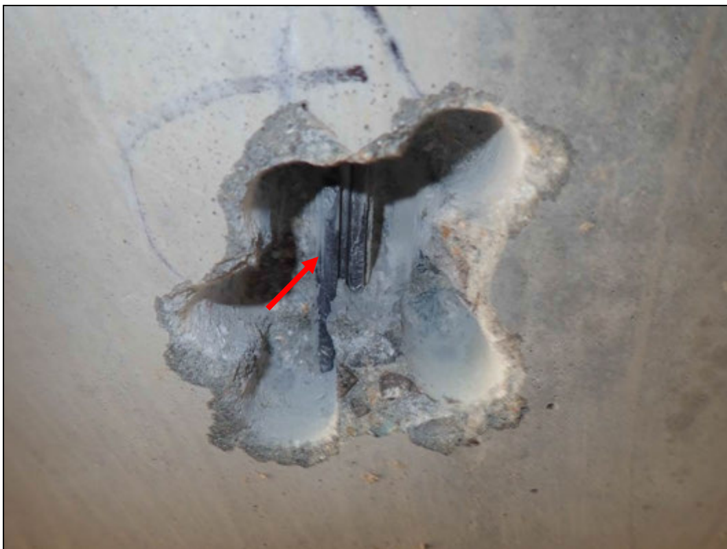
Foto 28: Detail sondy S28, předpínací výztuž nosník KA 61, spodní líc nosníku č. 12, cca 1/2 rozpětí. Na předpínací výztuži nebyla nalezena koroze. Kanálek zcela vyplněn injektážní směsí. Krytí předpínací výztuže cca 35 mm. Poloha viz Příloha 1.
