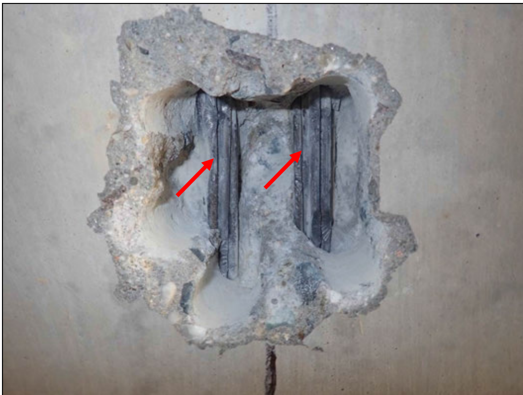
Foto 7: Detail sondy S7, předpínací výztuž nosník KA 61, spodní líc nosníku č. 7, cca 1/3 rozpětí. Na předpínací výztuži nebyla nalezena koroze. Kanálek zcela vyplněn injektážní směsí. Krytí předpínací výztuže cca 45 mm. Poloha viz Příloha 1.
